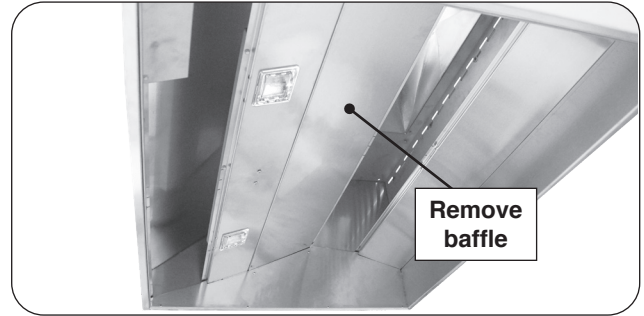
Fig. 12-1 Remove baffle
